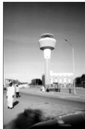
Château d'eau à N'Djamena
