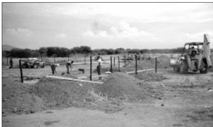
Le chantier du nouveau centre de documentation vient de débiter à Gaborone
