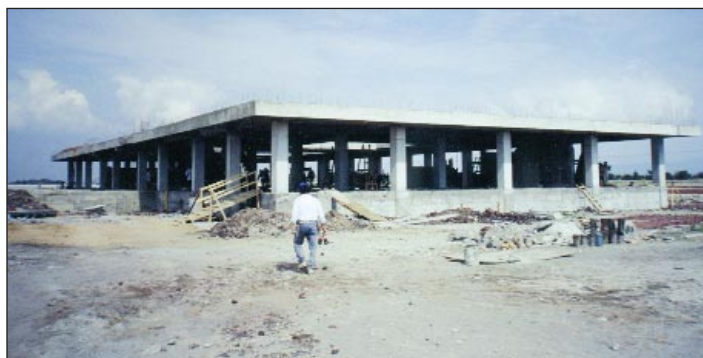
Texcoco : le chantier de construction vu de l'extérieur
