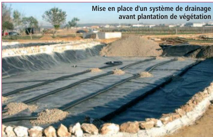
Mise en place d'un système de drainage avant plantation de végétation
