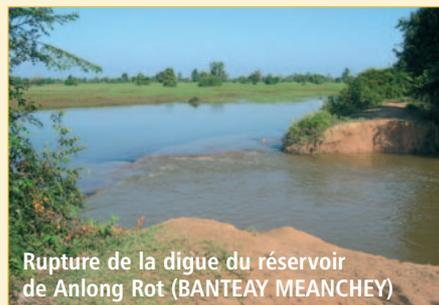
Rupture de la digue du réservoir de Anlong Rot (BANTEAY MEANCHHEY)
