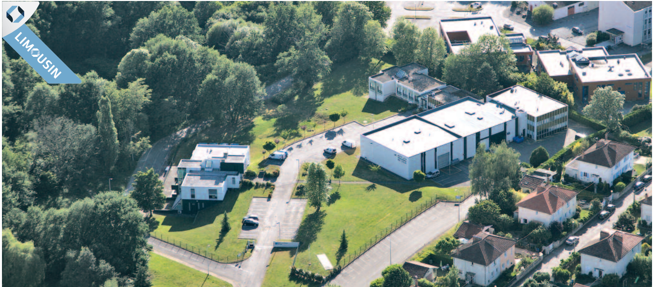
Nos installations à Limoges
