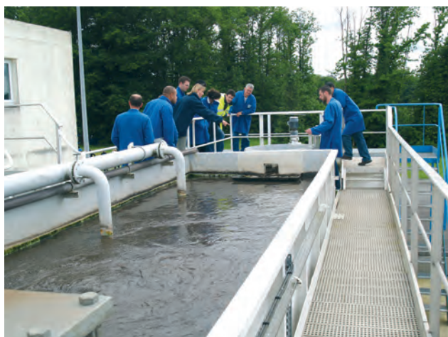
Travaux pratiques sur pilote de traitement à boues activées
