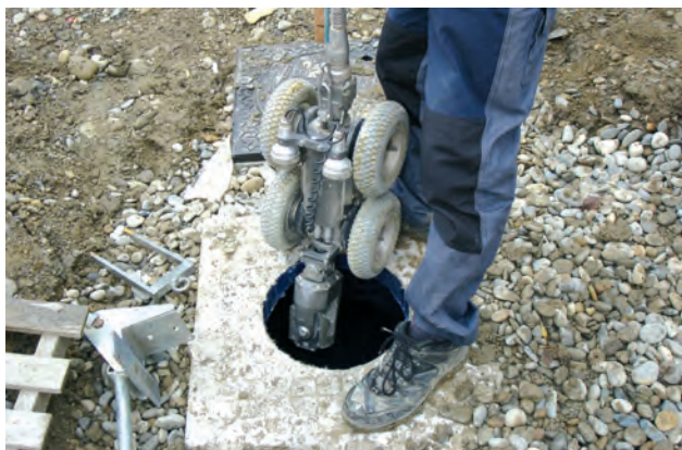
Inspection télévisée sur réseau d'entraînement
