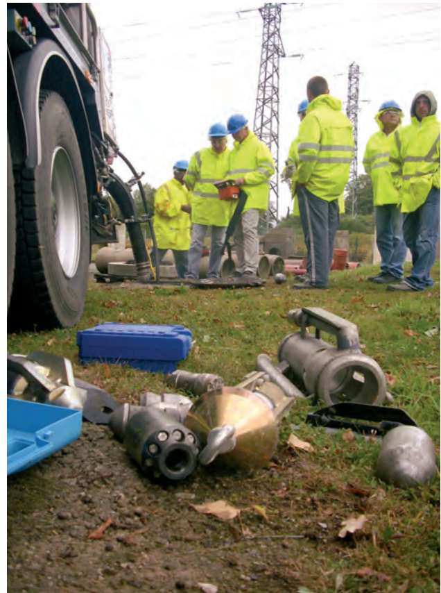
Travaux pratiques d'hydrocurage
