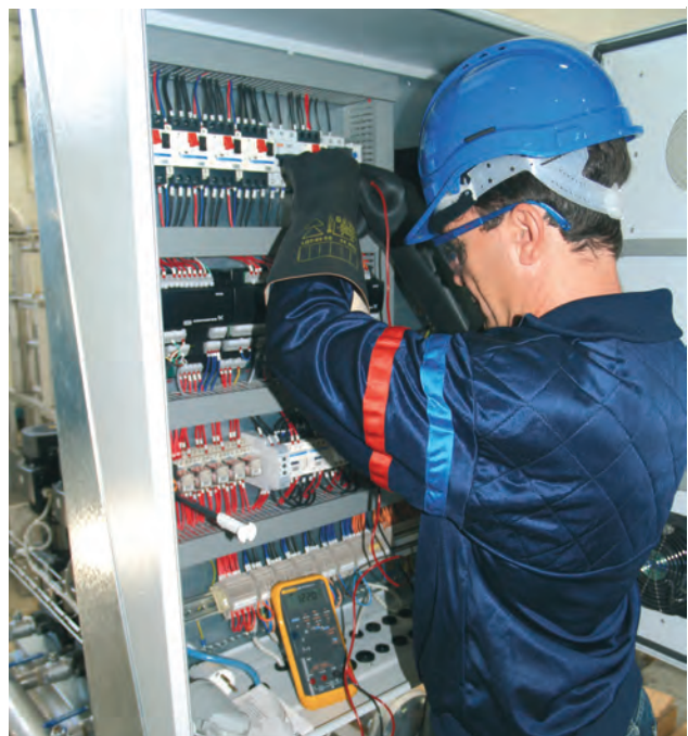
Intervention sur tableau électrique
