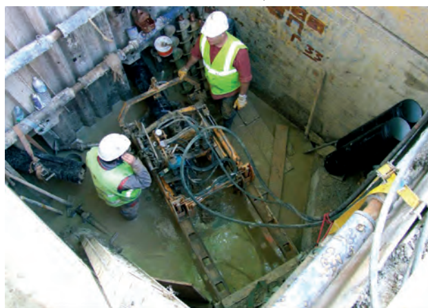
Forage guidé à la tarière pour la mise en place d'une canalisation d'assainissement gravitaire (Patrice SCHNEIDER - FSTT)
