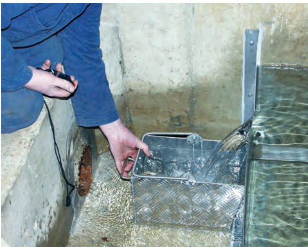
Mesure de débit sur captage d'eau
